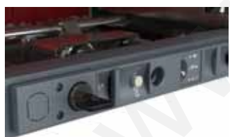
Блокировка в положении «выквачено» с помощью встроенного замка
