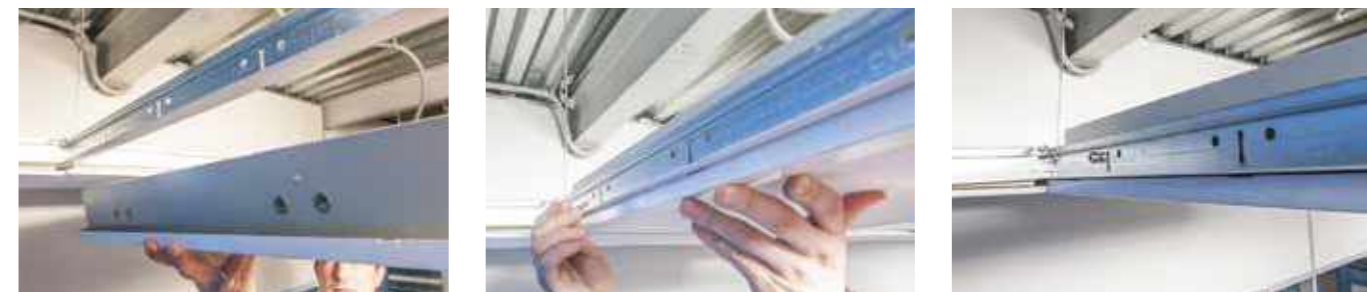
На второй стороне светильника предусмотрен винтовой крепеж, при помощи которого светильник фиксируется в подвесной системе потолка ROCKFON System T24 X. Также винтовой крепеж позволяет осуществлять регулировку положения светильника в ячейке относительно панелей потолка.
