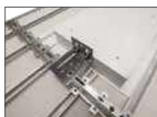
Надежный крепеж для реечного потолка
