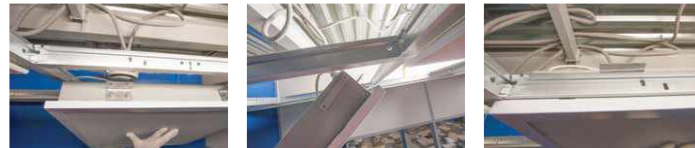
Светильник устанавливается одной стороной на подвесную систему потолка, при помощи установленных на светильнике монтажных скоб.
