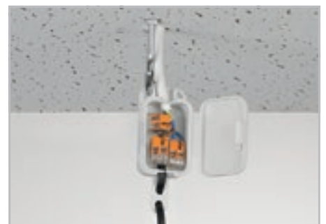
Подвесное присоединение светильников в подвесных потолках
