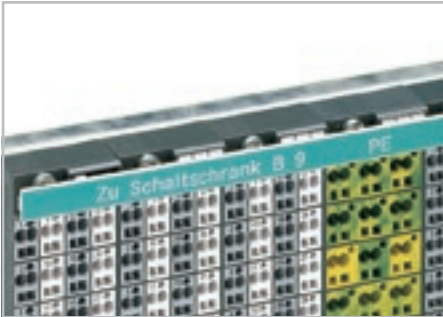
Сплошная маркировочная полоска WFB. Вставляется в разъем для маркировки и в групповой держатель маркировки матричной коммутационной панели.
