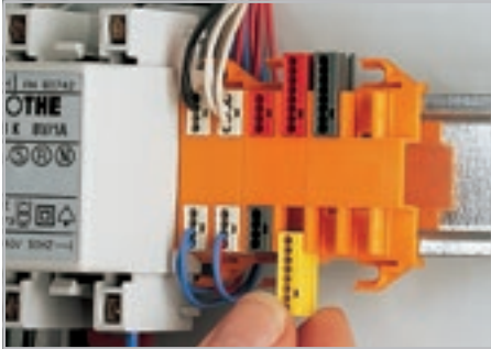
Установка клемм PUSH WIRE® для распределительных коробок в держатель.
