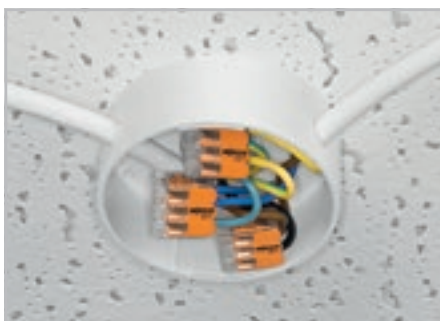
Распределение питания для потолочных светильников
