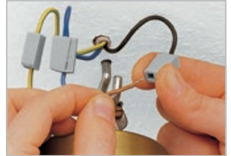
Отключение: нажать кнопку и извлечь проводник.
