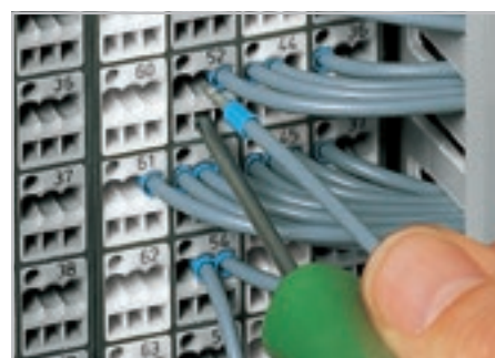
Подключение проводников с наконечниками.
