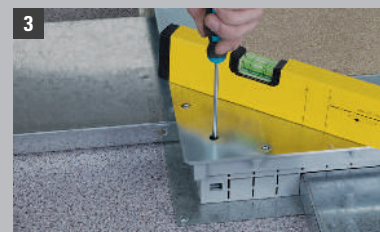
3 Отрегулировать с помощью винтов
