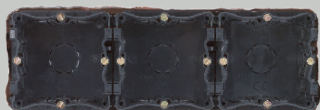
Установка механизмов Simon 82
