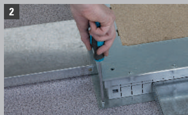
2 Вставить кабель-каналы и привинтить к полу
