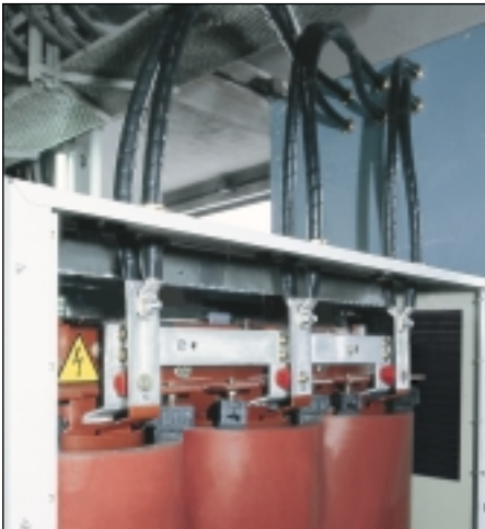
Присоединения ВН сверху через разъемы (1) (на заказ)
