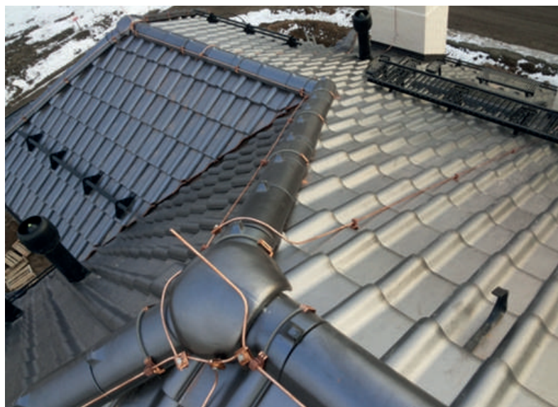
Молниеприемная сетка на скатной кровле
