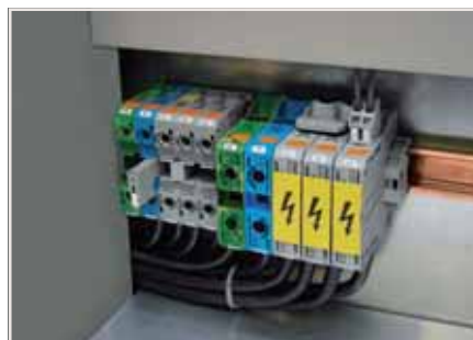
Благодаря боковому вводу даже проводники больших сечений с ограниченной гибкостью можно легко подключить.
