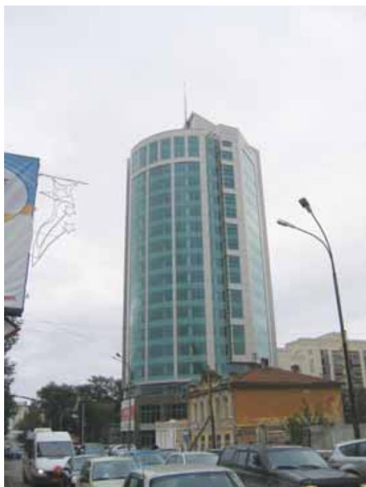
Бизнес-центр "Палладиум" в Екатеринбурге
