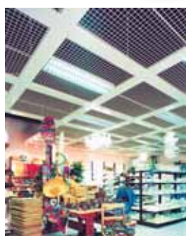
Интегрированные фальш-потолки
