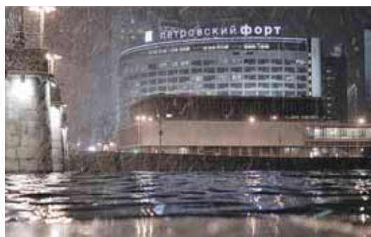
Бизнес-центр "Петровский Форт" в Санкт-Петербурге
