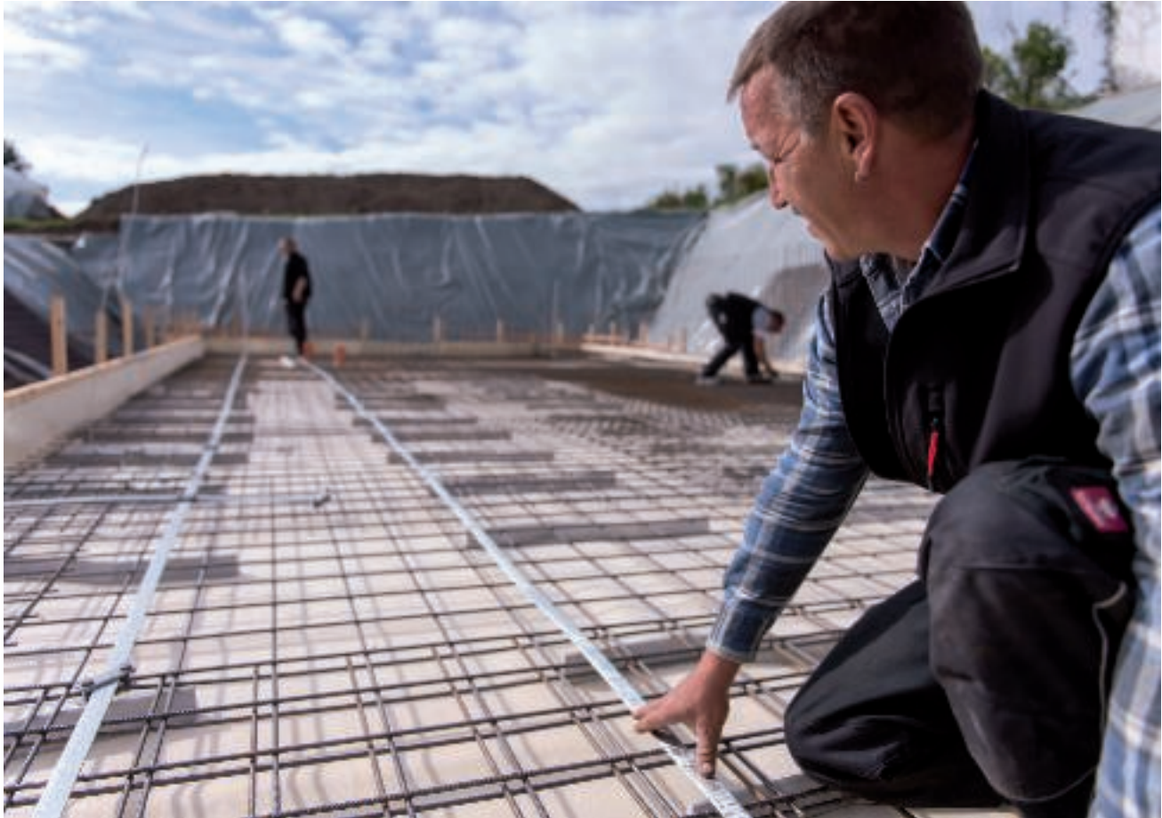
Прокладка фундаментного заземления
