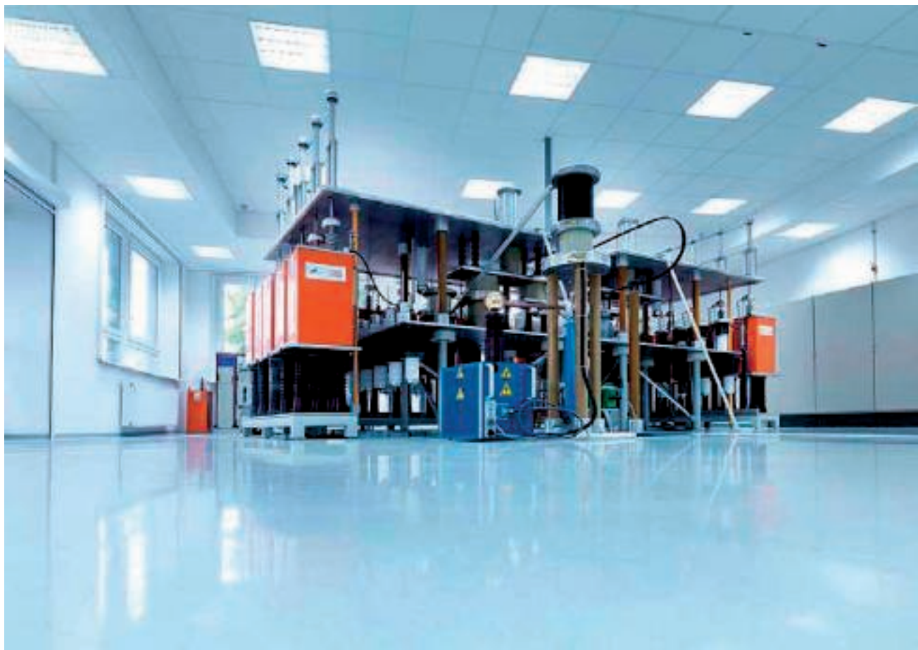
Генератор токов молнии
