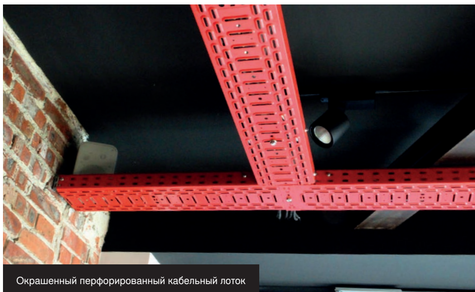
Окрашенный неперфорированный кабельный лоток Музей брецеля, Эрдманнхаузен
