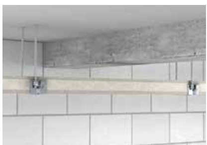
Подвесной монтаж на соединительных элементах.
