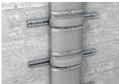
Крепление бандаж с помощью металлических монтажных лент и реек.
