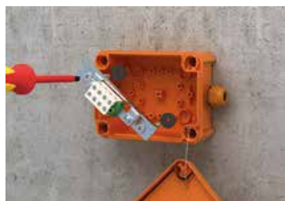
Настенный монтаж огнестойкой распределительной коробки FireBox.
