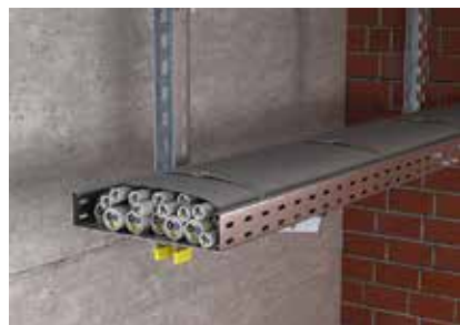
Бандажирование кабельного пучка на несущих системах.
