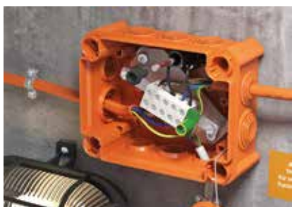
Ввод кабеля с помощью уплотнителей.
