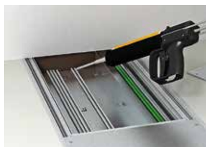
Нанесение огнестойкой пены непосредственно под стену.
