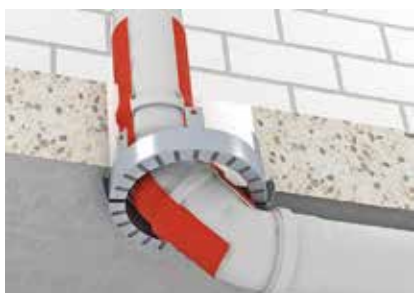
Муфты для труб в месте прокладки.
