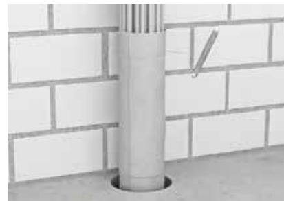
Фиксация бандежа с помощью проволоки.
