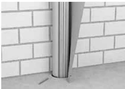
Установка огнестойкого бандажа.
