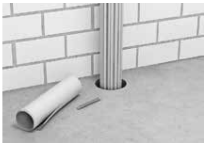
Подготовка кабельной проходки.
