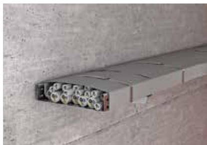
Полное бандажирование кабеля в кабельной лотке при настенном монтаже трассы.
