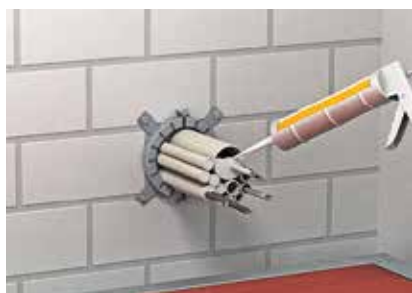
Заполнение концов труб огнестойким защитным средством DSX.
