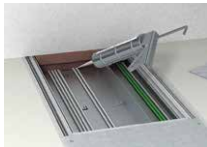
Заделать стыки шпатлевкой FBA-SP.
