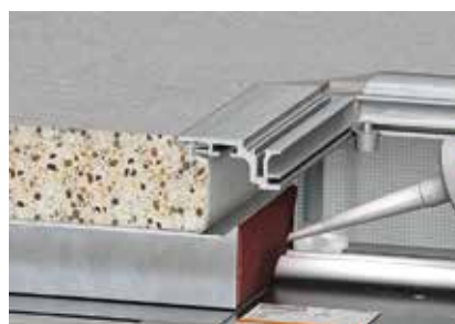
Заделать стыки между кабелями и блоками шпатлевкой FBA-SP.
