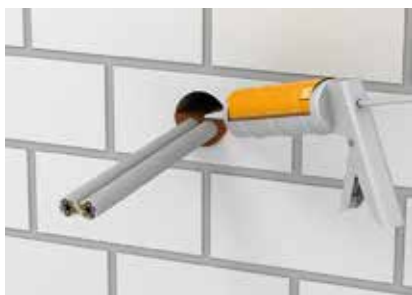
Заполнение отверстия шпатлевкой FBA-SP.
