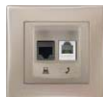
Телефонная и компьютерная розетка
